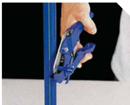
Ucięcie wystającej części kołka
